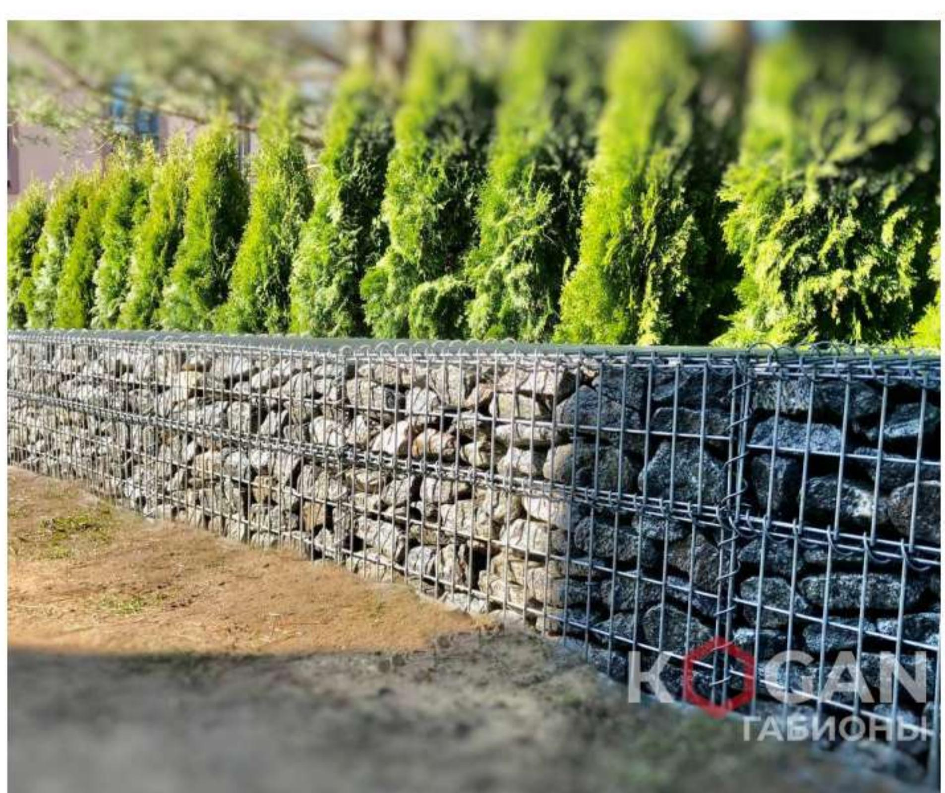
Габионы из сварной сетки отличаются повышенной жесткостью и огромной вариативностью форм (возможна любая геометрия).
