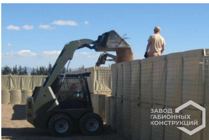
ГНТ представляют собой быстроразвертываемые сетчатые конструкции из габионной сетки и защитной оболочки, заполняемые на объекте механизированным способом грунтом или песком, для создания укрывных защитных стен. Продукция на 100% состоит из отечественного сырья. Текущие производственные возможности завода позволяют выпускать до 5000 серийных комплектов ГНТ в месяц (что эквивалентно более чем 22 тыс. м3 фортификации).
