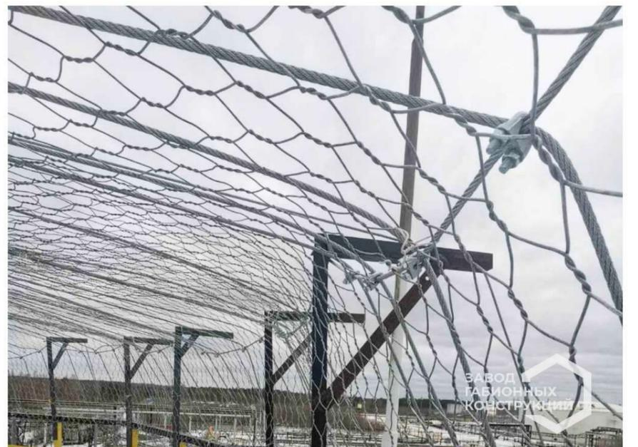
В строительной сфере сетка двойного кручения применяется для производства габионов по ГОСТ Р 52132-2003, удерживающих тонны камня, защиты от камнепадов автомобильных и железных дорог, а также для накопления и стабилизации растительных грунтов на склонах гор, откосах. Благодаря высоким прочностным свойствам сетка двойного кручения в один слой может удерживать падение камней размером до 1 м.
