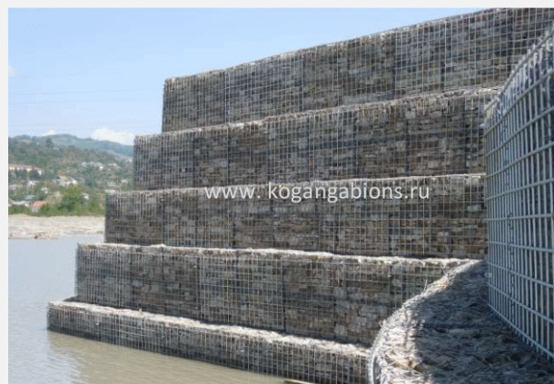
Применение отдельных сварных панелей для дополнительной защиты плетеных габионов (при подъеме уровня воды, обледенении, безопасности в пешеходных зонах)
