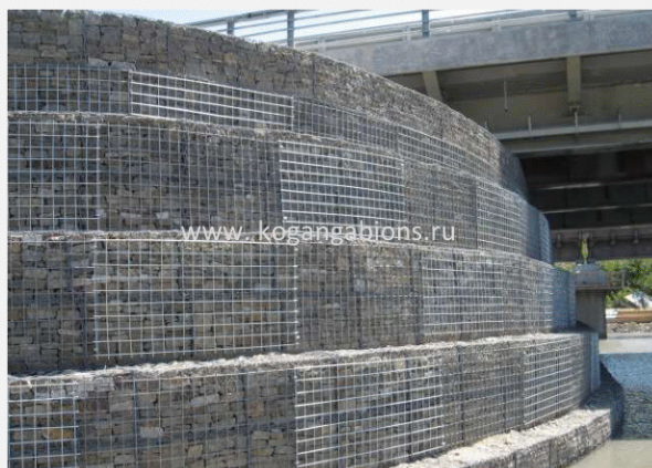
Применение отдельных сварных панелей для дополнительной защиты плетеных габионов (при подъеме уровня воды, обледенении, безопасности в пешеходных зонах)
