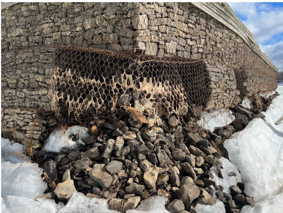
Рисунок 16 – Последствия воздействия льда
